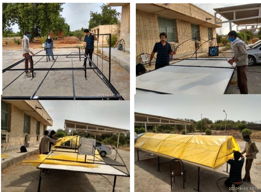
شکل ۴- مراحل نصب خشک کن تونلی آفتابی
