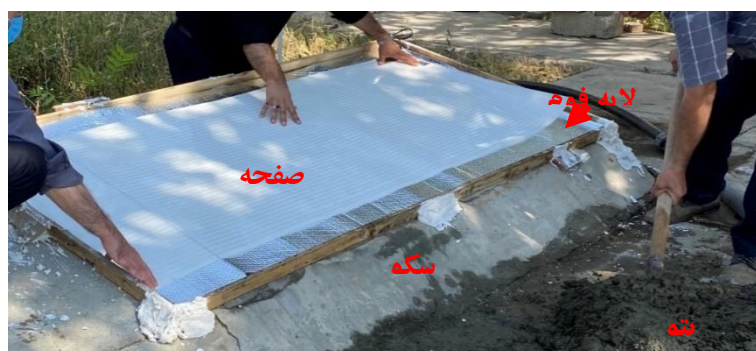
شکل ۳- نصب صفحات گرمایشی هوشمند روی سکو
