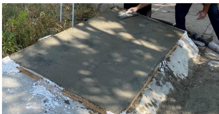
شکل ۴- پوشش دادن بارگاه با صفحات هوشمند با بتن
